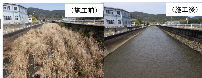
磯部川緊急浚渫推進事業 (三重県)
