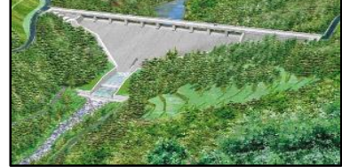
排水機場整備 (三重県)
