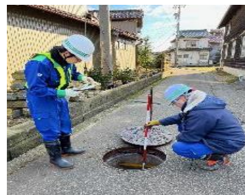
▲一次調査(マンホール内確認)の様子
