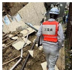
▲被害認定調査の様子
