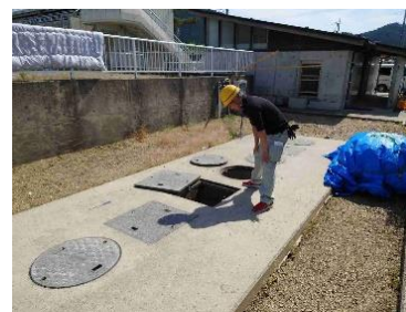
▲浄化槽を確認する様子
