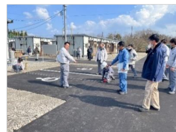
▲完成検査の様子
