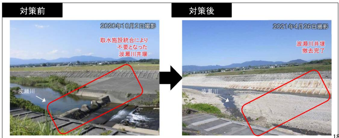
図 25 波瀬川下流部堰撤去事業（波瀬川井堰）
