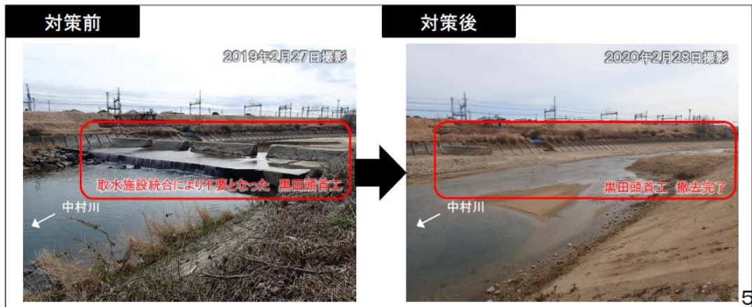
図 24 中村川下流部河道掘削事業（黒田頭首工）
