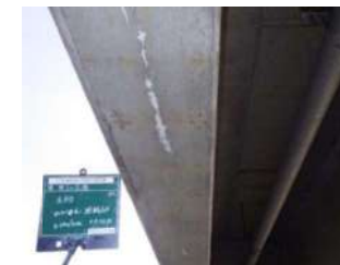
防水措置 (損傷少)
