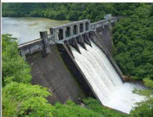
既設丸山ダム(昭和31年3月完成)
