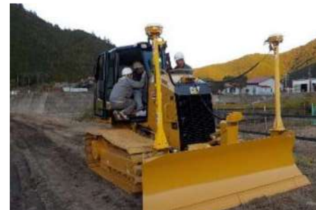
ICT活用工事（ICT建機施工）
