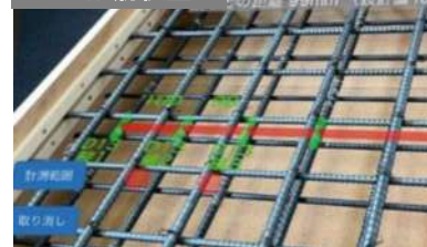
スキャナで鉄筋間隔を自動計測し画面表示
