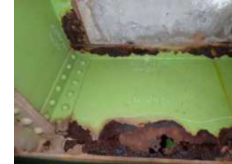
当て板補修 (損傷大)
