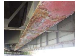
再塗装 (損傷少)
