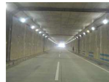
大型カルバート ひびわれ補修
