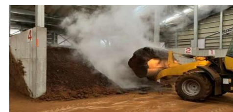
(高島浄化センター(滋賀県)コンポスト化施設)
