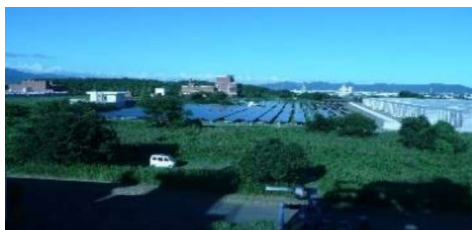
(豊川浄化センター(愛知県)太陽光発電施設)
