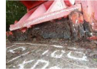
部材交換 (損傷大)
