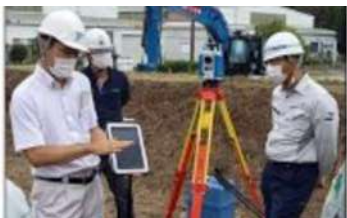
UAVによる起工測量研修
