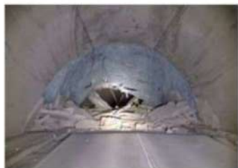
<国道249号 中屋トンネル>
