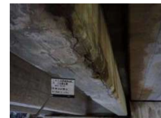
断面修復 (損傷大)
