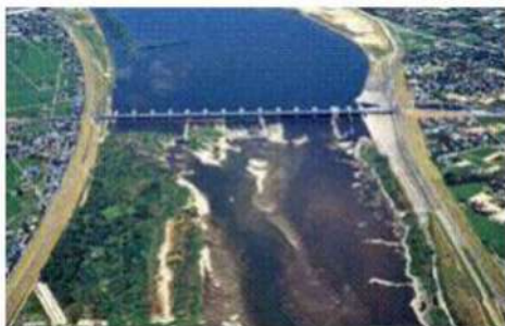
木曾川大堰付近(平成6年渇水時)
