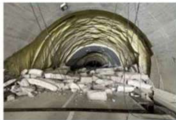
<国道249号 大谷トンネル>
