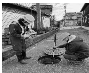
▲一次調査(マンホール内確認)の様子
