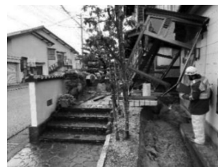
▲応急危険度判定活動の様子
