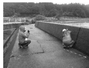
▲漁港被害の調査の様子
