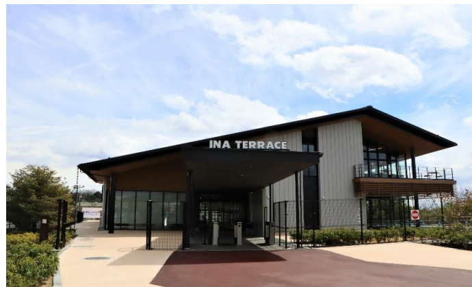
(福利厚生施設「イナテラス」外観)
