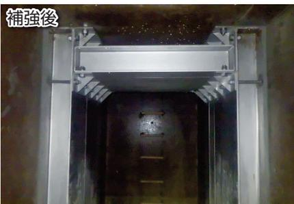
マンホール内を鋼製材により耐震補強
