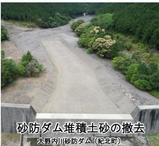
砂防ダム堆積土砂の撤去
