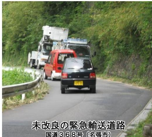
現在の道路構造令は、車道の幅員を5.5m以上としていますが、これを満たさない未改良の道路では、車両のすれ違いが困難であるなど、災害時の緊急輸送を円滑に実施することが出来ないリスクがあります。このようなリスクがある道路が、第二次緊急輸送道路で約19km確認されています。
