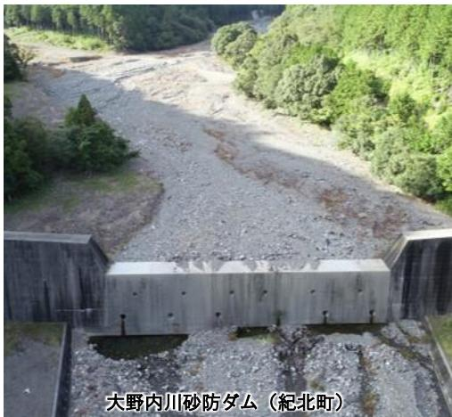
砂防ダムの堆積土砂が満杯になると、さらに発生した土砂を貯めきれず、豪雨時に土石流が発生するリスクがあります。
