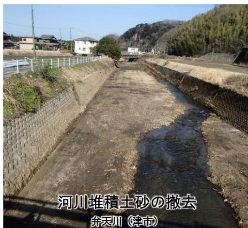
県の河川事業により、毎年の堆積量を上回る約22万m<sup>3</sup>を撤去します。加えて、民間の砂利採取について、制度を拡充することにより、毎年15万m<sup>3</sup>程度の撤去を目指します。これらにより、**毎年合計約37万m<sup>3</sup>を撤去**し、蓄積した土砂も含めて計画的な撤去を進めます。
