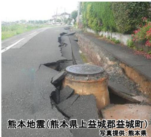
阪神淡路大震災以前の基準で設計された下水道管路は、供用中に発生する確率の高い地震(L1地震動)をもとに設計されており、南海トラフ地震等の大規模地震が発生した場合損傷し、下水が流下出来ない事態や道路陥没等が生じるリスクがあります。この様なリスクの可能性がある開削あるいは推進工事で施工された管路の区間が、約2kmあります。
