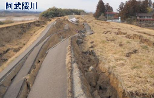
河川堤防は日本海中部地震以前は地震による外力を考慮しておらず、大規模地震が発生した場合、沈下や損傷といった変形が生じ、土地の低いゼロメートル地帯では、河川の流水が越流した際に浸水被害が長期化するリスクがあります。このようないリスクの可能性があるゼロメートル地帯における河川堤防の区間が約6km確認されています。
