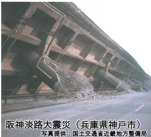
阪神淡路大震災以前の基準で設計された橋梁は、関東大震災クラスの地震をもとに設計されており、阪神淡路大震災クラス等の大規模地震が発生した場合、橋脚等が損傷し、長期間通行が出来ないリスクがあります。このような橋梁等が、緊急輸送道路で553橋確認されています。
