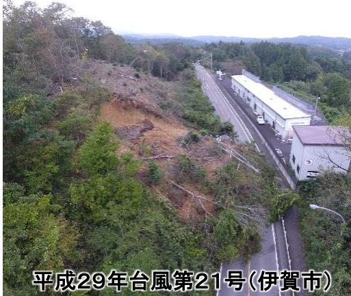
道路の法面や盛土において、急な勾配、水を含むと強度が低下しやすい地質、表層で湧水の発生、小規模な亀裂が存在するなど、豪雨時に崩壊するリスクがある箇所が、緊急輸送道路で149箇所確認されています。
