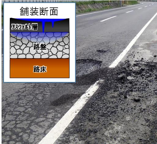
老朽化に伴う舗装のひび割れが、アスファルト層を貫通すると、雨水が路盤まで浸透し、路盤の支持力が低下するなど、舗装の損傷が拡大し、自動車等の走行に著しい支障が生じます。このようなリスクがある道路が、緊急輸送道路で約57km確認されています。
