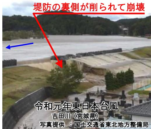
想定を超える大雨で河川の水が堤防を越えると、堤防の裏側が削られて決壊するリスクがあります。背後に人家等がある箇所で、過去に氾濫の発生や堤防高等が不足している河川堤防が約38km確認されています。
