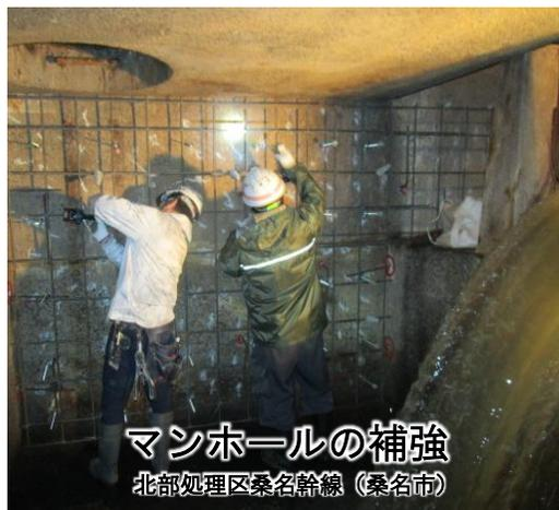
将来にわたって考えられる最大級の強さを持つ地震(L2地震動)発生後も下水を上流から下流へ流せる状態や道路の交通機能を確保出来るようにマンホールの内側を鉄筋とコンクリート等で補強する対策を講じます。
