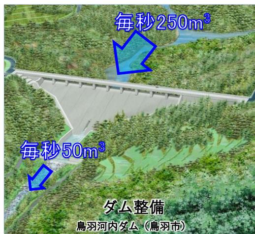
鳥羽河内ダムを整備することにより、河川のピーク時の流量を1/5に抑え、浸水被害を軽減します。
