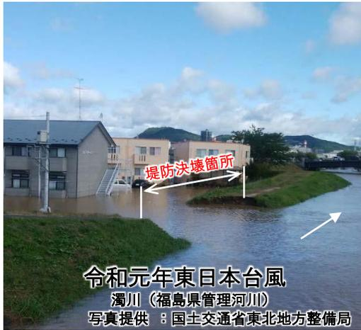
水害による被害軽減を図るため、洪水予報河川、水位周知河川は、洪水浸水想定区域図を作成・公表しています。しかし、令和元年東日本台風では、それ以外の中小河川でも多数の堤防が決壊、人的被害が発生しており、この様な中小河川が508河川あります。
