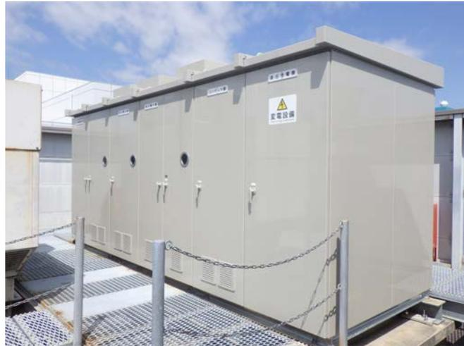
更新が完了した北勢水道事務所受変電設備（四日市市）
