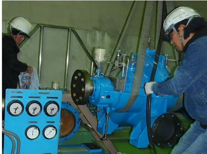
分解点検中の播磨浄水場送水ポンプ設備（桑名市）
