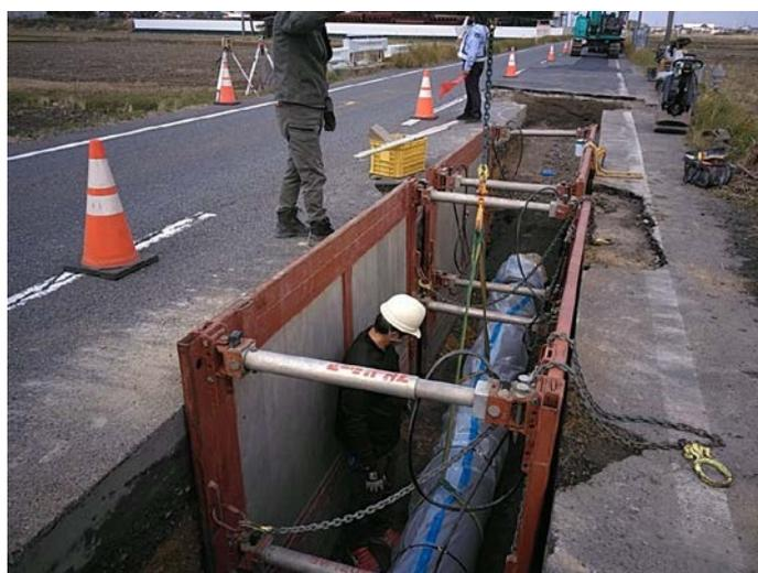
耐震管（内径300mm）布設工事の施工状況（桑名市）
