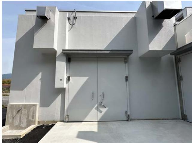
防水扉の設置が完了した勢和加圧ポンプ所（多気町）
