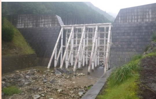
上流から流れてきたたくさんの土砂をとめています
