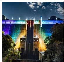
インフラツーリズム (碧ヶ野ダムライトアップ)
