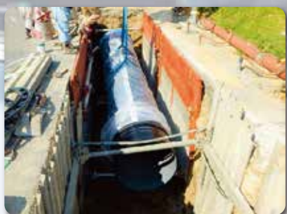
配水管布設替工事の施工状況
