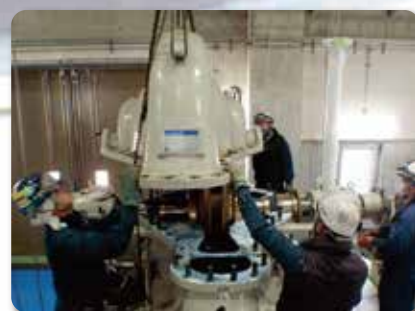
分解点検中のポンプ設備
