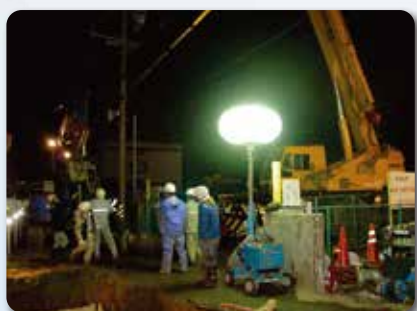
夜間の漏水復旧作業
