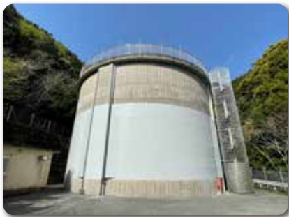
調整池の耐震補強
