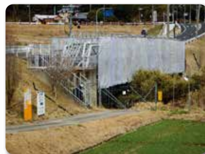
塗装塗替中の水管橋
