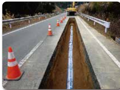
耐震管への布設替え
