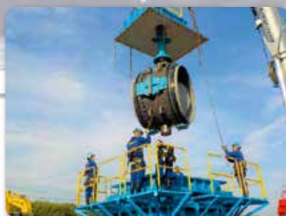
制水弁取替工事の施工状況
