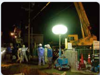
夜間の漏水復旧作業
