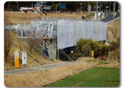
塗装塗替中の水管橋
