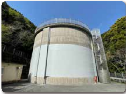
調整池の耐震補強
