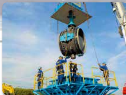
制水弁取替工事の施工状況
