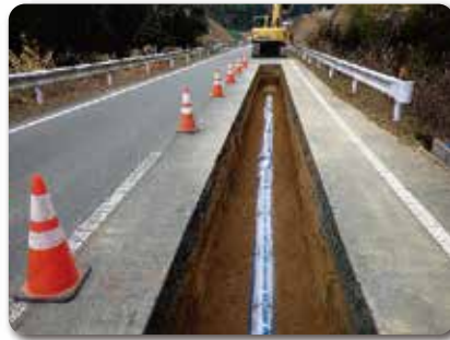
耐震管への布設替え
