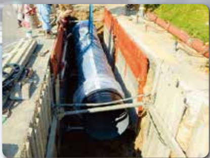
配水管布設替工事の施工状況
