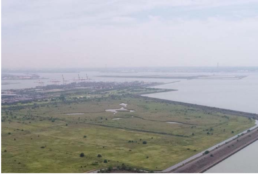
図 1-3 保全区の現況(木曾川上空より撮影、撮影日:令和 3 年 8 月 26 日)
