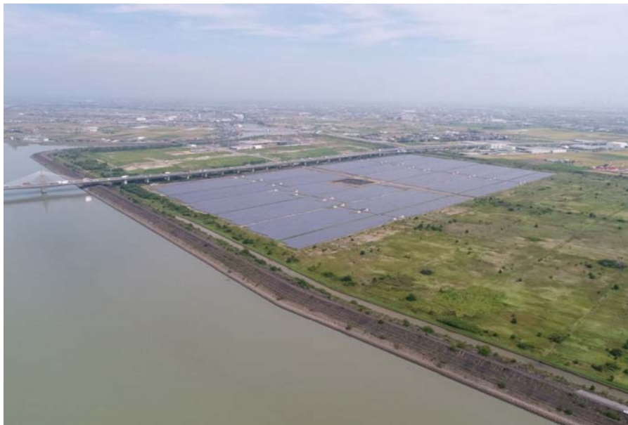
図 1-2 新エネルギーランド(木曾岬干拓地メガソーラー発電所)の現況 (木曾川上空より撮影、撮影日:令和 3 年 8 月 26 日)
