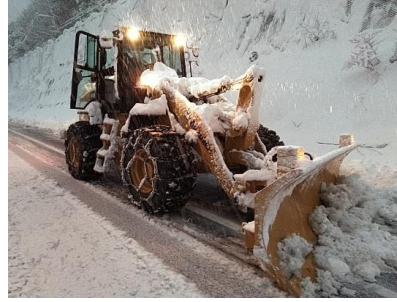
地域の建設企業による除雪作業
