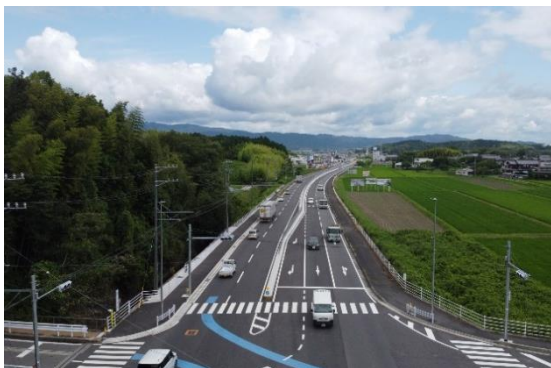
一般国道368号(伊賀名張拡幅1工区)道路改良事業 (伊賀市)
