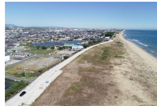
上野地区海岸高潮対策事業 (津市)
