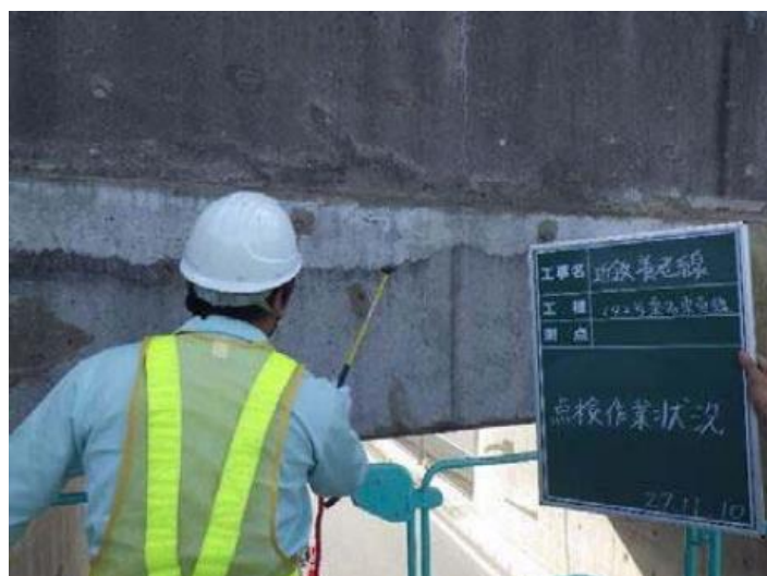
大型カルバート 点検状況
