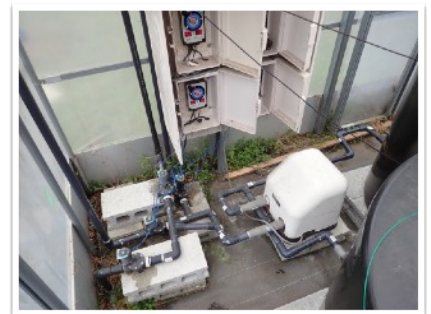
ポンプとタイマーと電磁弁 4系統独立設定可能な設計です。
