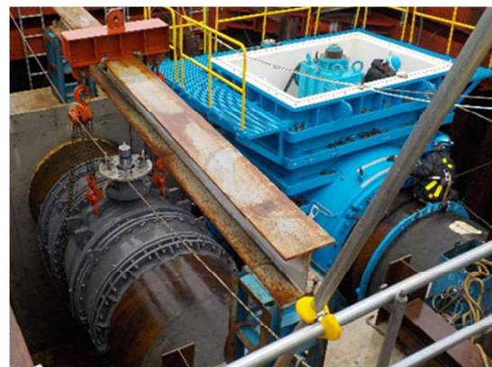
不断水工法*による制水弁設置状況
