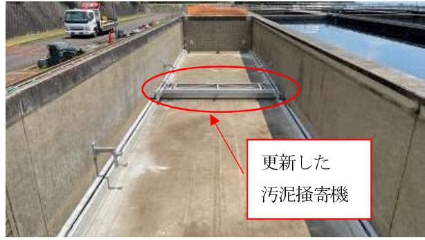
水沢浄水場（四日市市） 沈澱池汚泥掻寄機の更新状況
