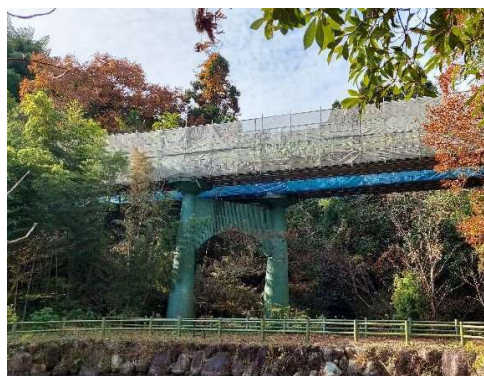
塗り替え中の志知水管橋（桑名市）
