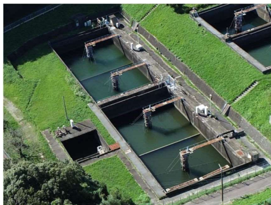
耐震設計中の山村浄水場（四日市市） 排水処理施設
