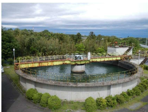
耐震設計中の伊坂浄水場（四日市市） 排水処理施設
