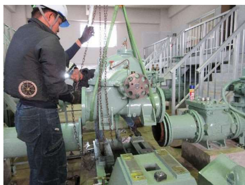
分解点検中の新屋敷取水所（松阪市） ポンプ設備
