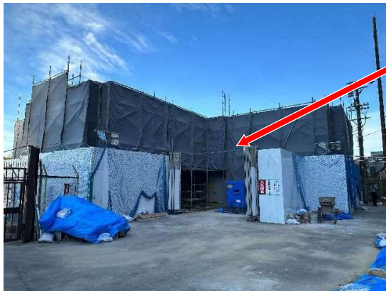
浸水・土砂対策工事中の勢和加圧ポンプ所（多気町）
