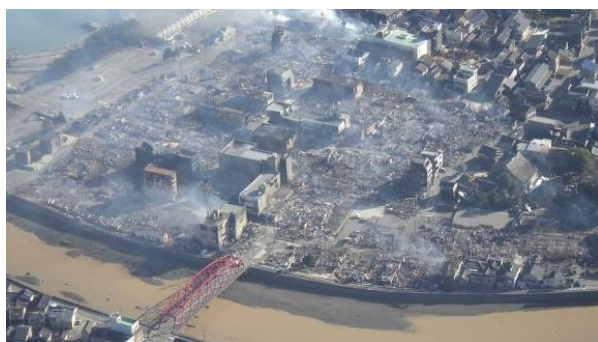
1/2 輪島市大規模火災現場を上空から撮影
