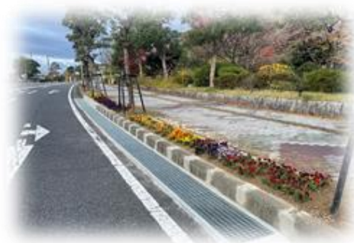
雨水浸透側溝（県庁前）
