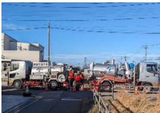
二次調査状況 （超高压洗浄車(左)と強力吸引車(右) による管清掃）
