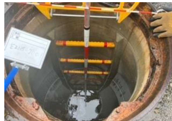
一次調査状況 （マンホール内確認）
