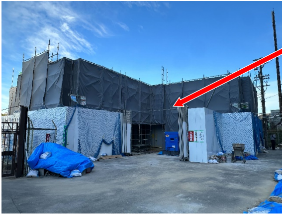
対策工事中の勢和加圧ポンプ所（多気町）
