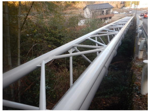
塗り替え後の穴倉川水管橋（津市）
