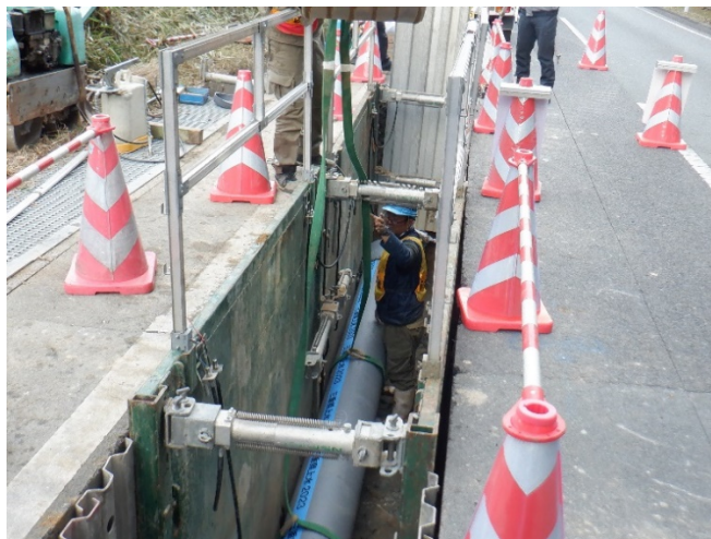
送水管布設替工事の施工状況 (多気町)
