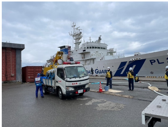
海上保安庁巡視船からの補水状況 (七尾港)
