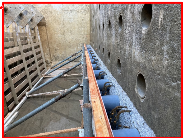
整流壁の耐震補強状況 (コンクリート増し打ち用の型枠設置)
