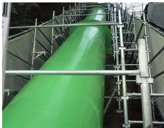
塗り替え中の志知水管橋（桑名市）
