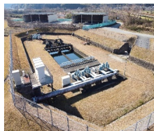
浸水対策予定の施設 （高野取水施設）
