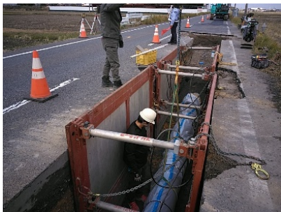
送水管布設替工事の施工例
