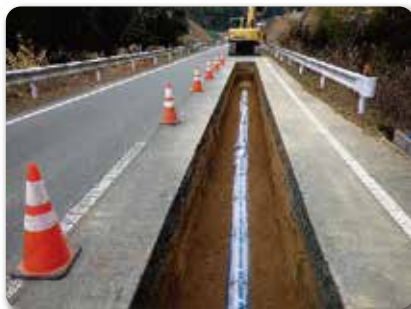
耐震管への布設替え
