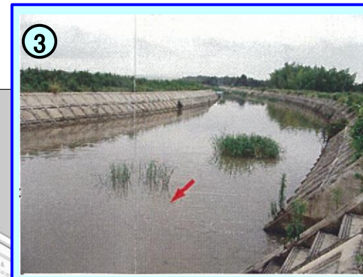
③左岸より上流を眺める。両岸とも張コンクリート護岸となっている
