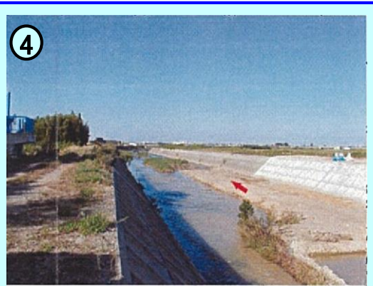
④左岸より下流を眺める。両岸ともコンクリート法枠護岸となっている。
