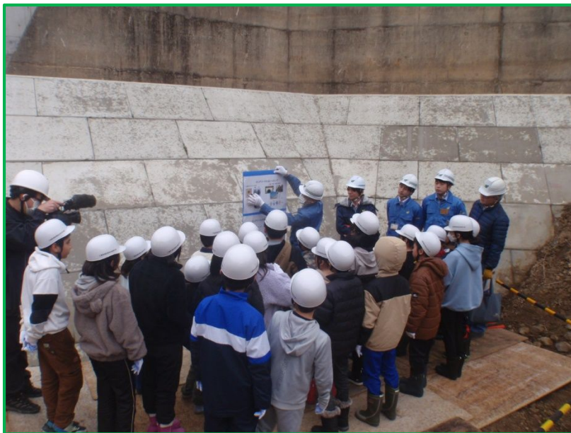
県職員によるコンクリートについての材料や特徴について説明の様子
