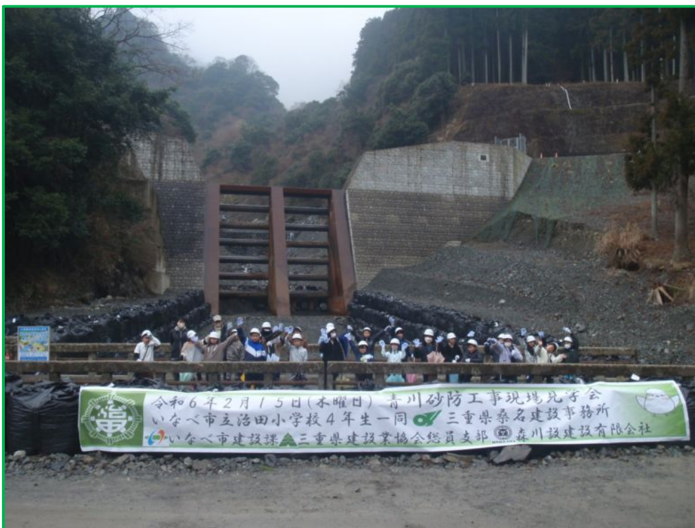
二級水系員弁川水系青川ほか1溪流砂防堆積土砂撤去工事
