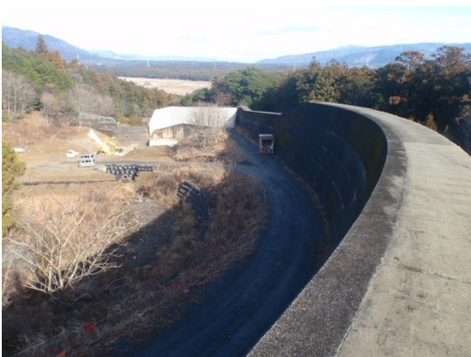
西之貝戸川砂防（4号えん堤嵩上工）工事
