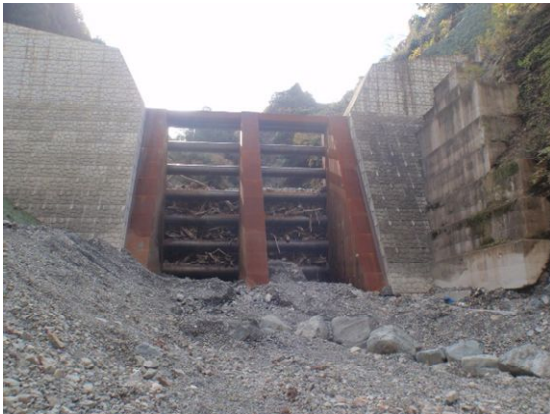
青川（後谷川）土砂堆積状況（令和5年8月） 堆積土砂撤去状況（令和6年1月時点）
