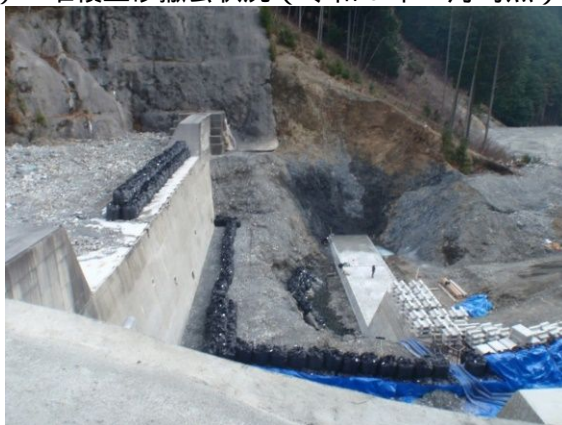
青川砂防（1号えん堤前庭保護工）工事
