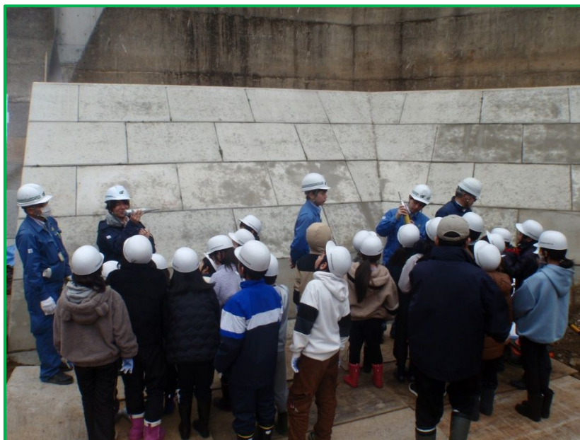
コンクリートの硬さを測る方法(シュミットハンマー)の説明と測定の様子
