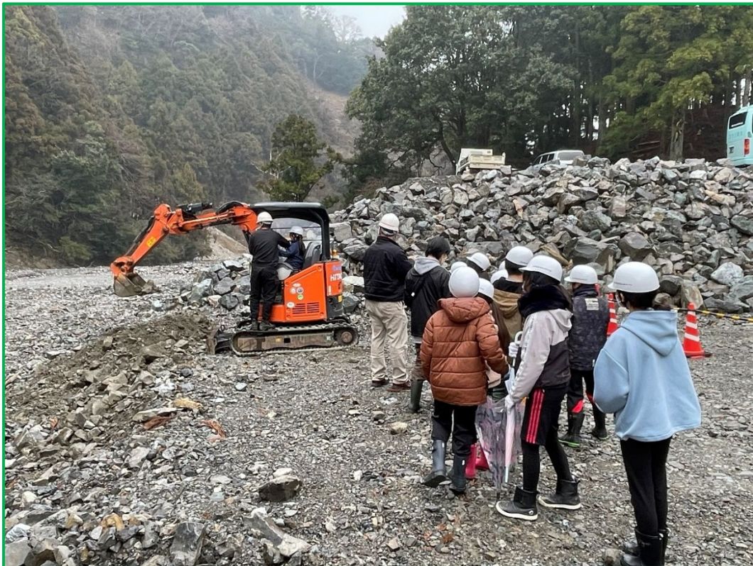
ミニバックホウによる土砂掘削の体験の様子
