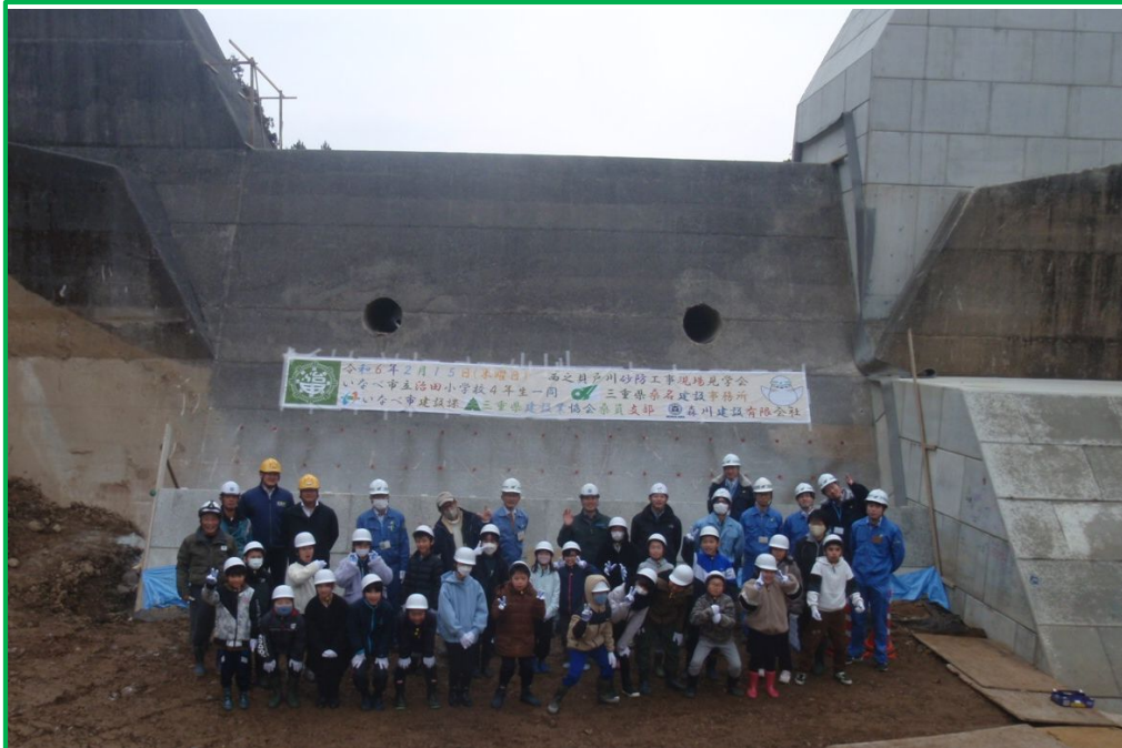
二級水系員弁川水系西之貝戸川国補通常砂防(4号えん堤嵩上工)工事
