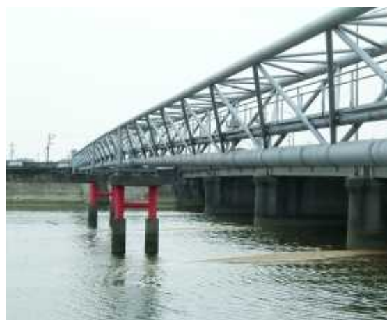
安濃川水管橋(津市)
