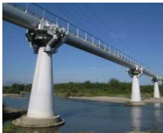
員弁川水管橋(桑名市)
