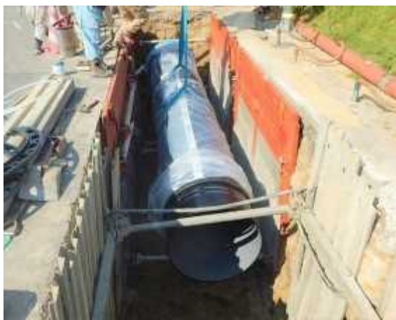
配水管(φ900mm)布設状況
