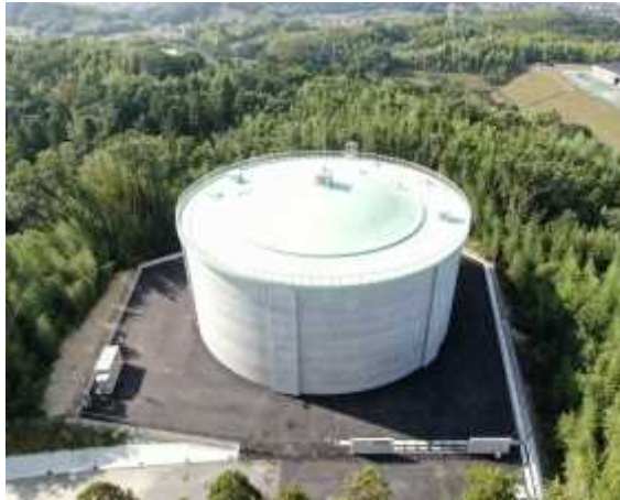
垂坂配水池(四日市市)
