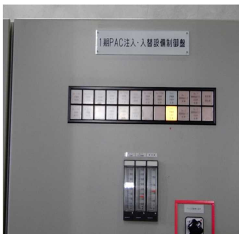
＜多気浄水場 (令和5年9月5日撮影)＞
