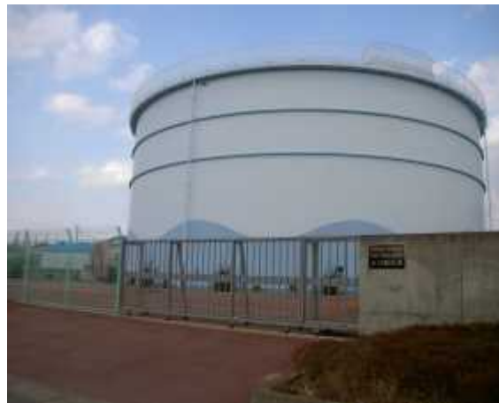
大口配水池(松阪市)
