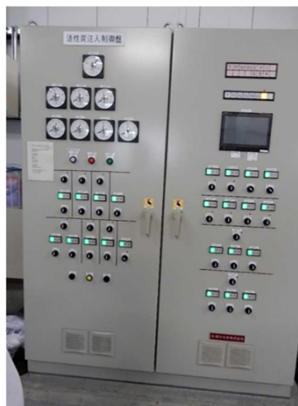
＜播磨浄水場 (令和5年8月24日撮影)＞
