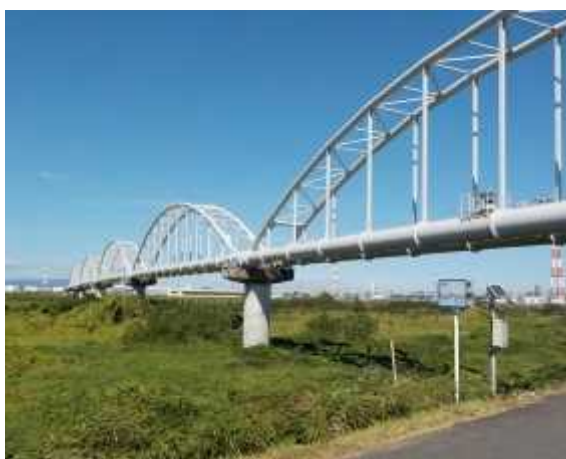
鈴鹿川第2水管橋(四日市市)
