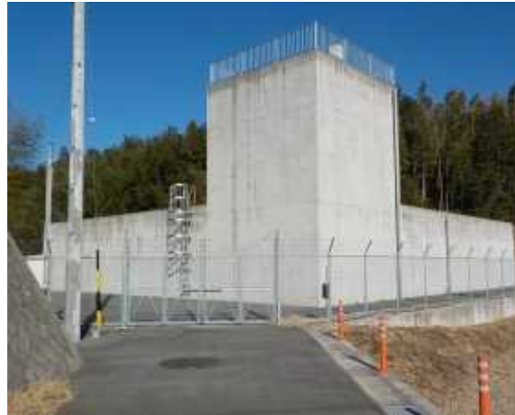
あいつ配水池(津市)
