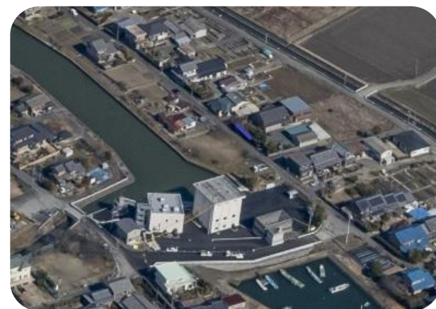
排水機場の整備
