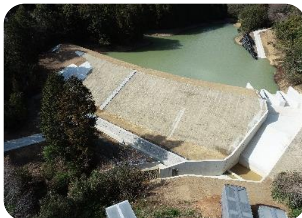
農業用ため池の整備
