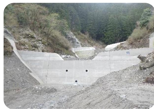
治山施設の整備
