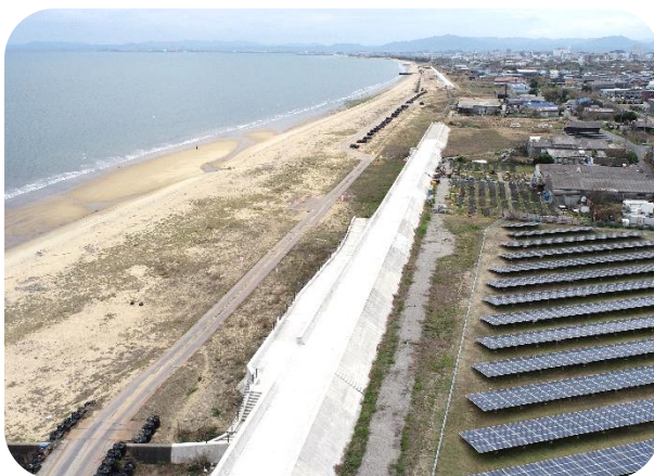
海岸保全施設の整備
