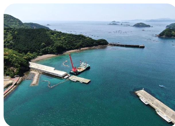
防波堤の整備
