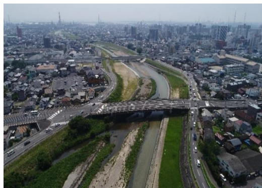
三滝川河川改修事業(四日市市)
