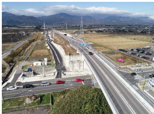
一般国道477号四日市湯の山道路改築事業(菰野町)
