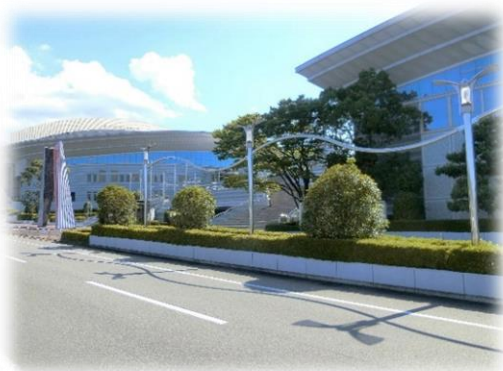
施設周辺の植栽 (三重県営サンアリーナ)
