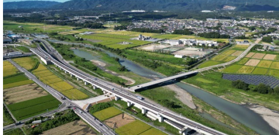
国道421号大安ICアクセス道路事業 (いなべ市)
