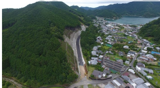
一般県道矢口浦上里線道路改良事業 (紀北町)
