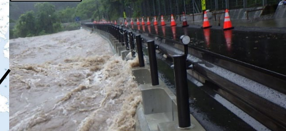
主要地方道伊勢南島線道路改良事業(度会町) 完成イメージ
