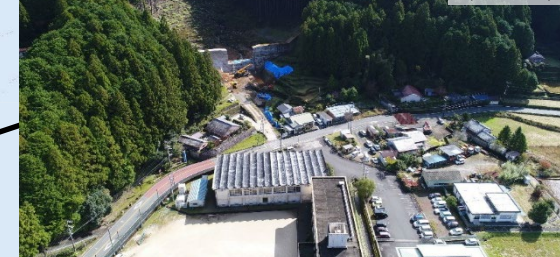
一級水系新宮川水系雨東谷通常砂防事業 (熊野市)
