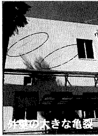
【図2-4-1. 施設のひび割れの状況】
