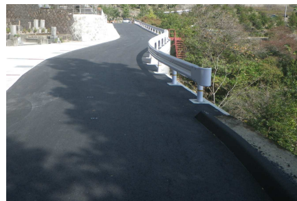
集落道 整備後
