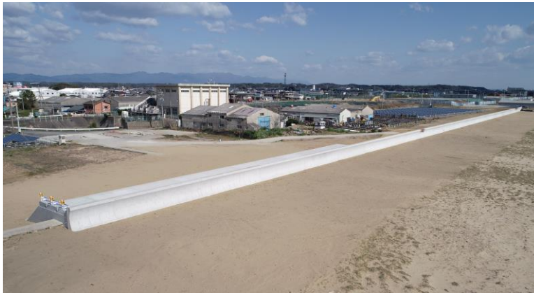
白塚漁港海岸における堤防整備
