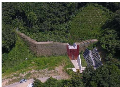
長平谷の砂防ダム（令和3年度完成）
