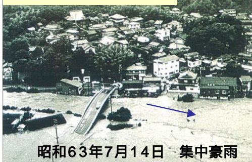
国道167号 灰原橋付近
