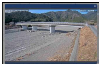
簡易型河川監視カメラ
