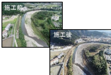
河川堆積土砂撤去事業(三戸川) 【三重県】
