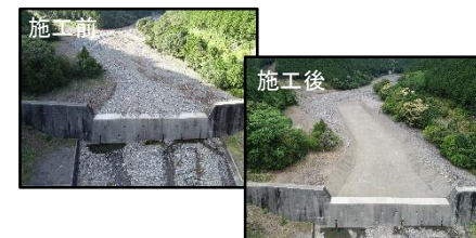
砂防堆積土砂撤去事業(大野内川) 【三重県】
