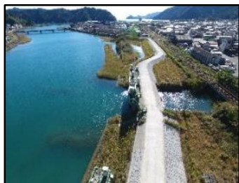
堤防強化事業(船津川) 【三重県】
