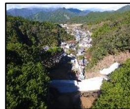
砂防堰堤の整備(猿谷) 【三重県】
