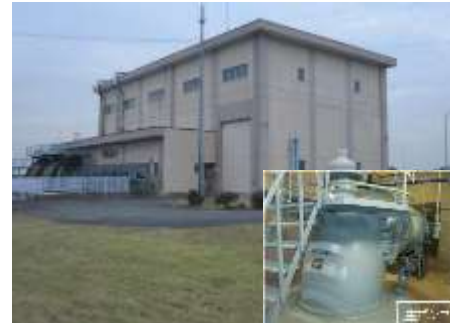
百々川排水機場延命化対策 (三重県)
