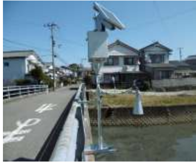
危機管理型水位計 （三重県）
