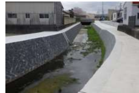
九手川における護岸整備 (松阪市)
