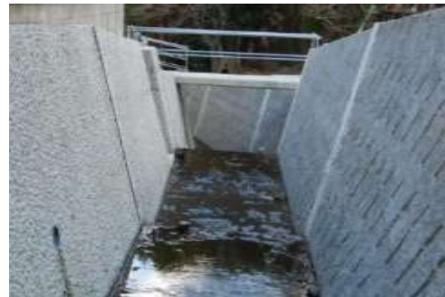
津市内河川における河道拡幅 （津市）
