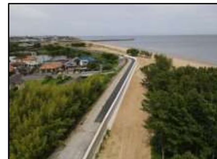
千里～白塚地区海岸における堤防整備 （三重県）
