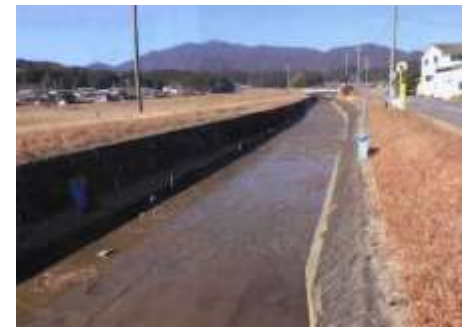
津市内河川における河道掘削 （津市）
