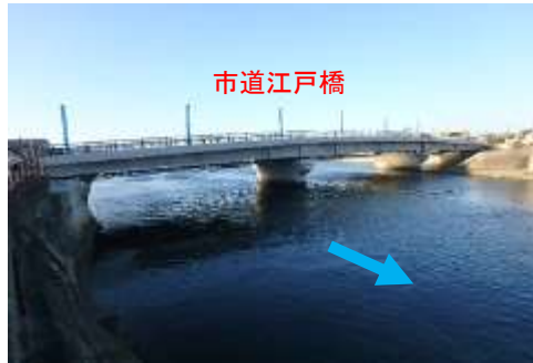
志登茂川における橋梁改築 （三重県）
