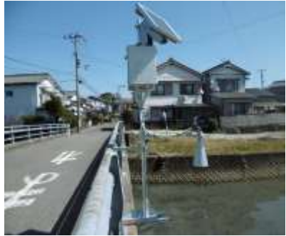
危機管理型水位計 （三重県）
