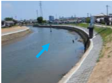
岩田川における築堤護岸 （三重県）
