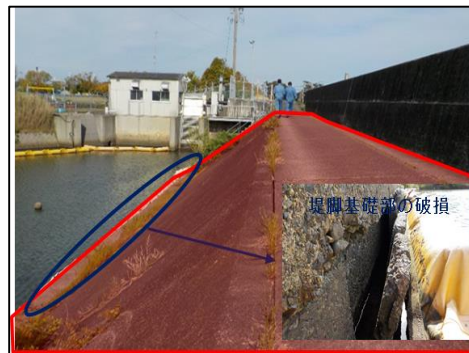
堀切川における堤防補強 （三重県）
