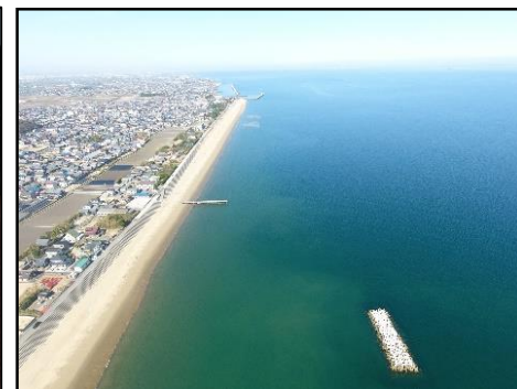
千代崎港海岸における離岸堤整備 （三重県）
