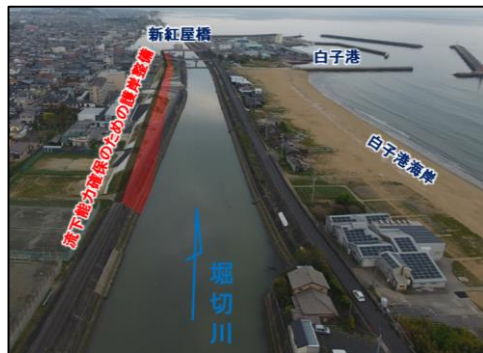
堀切川における護岸整備 （三重県）
