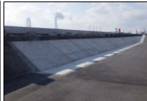
川越地区海岸における堤防整備 (三重県)
