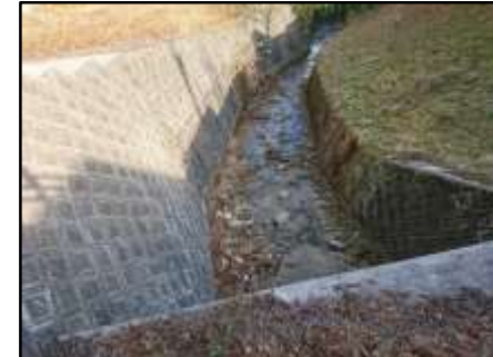
雲田川における浚渫 (菰野町)
