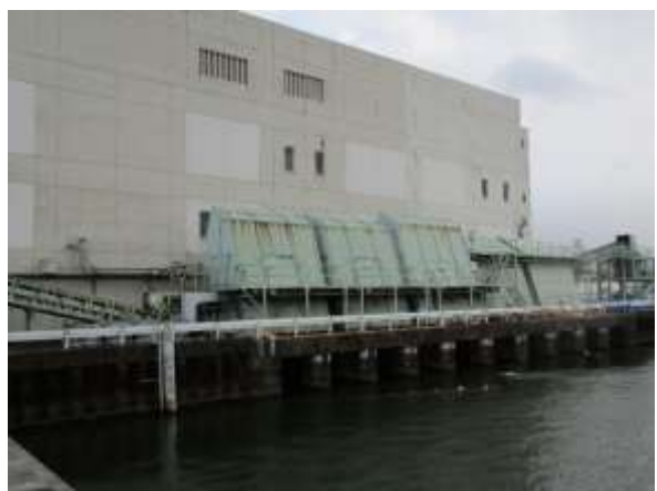
ポンプ場整備
