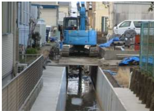
下水道（雨水排水）施設の整備
