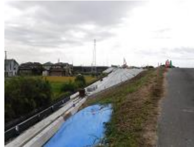
員弁川堤防強化事業 (三重県)
