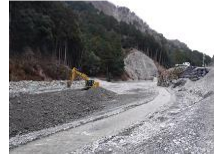
砂防堆積土砂撤去事業 (三重県)
