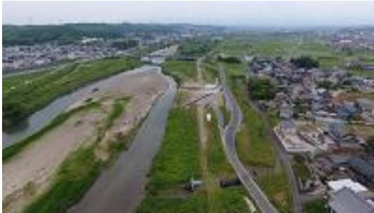
員弁川河川改修事業 (三重県)
