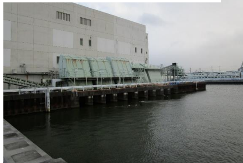
【川越町】川越排水機場ストックマネジメント事業
