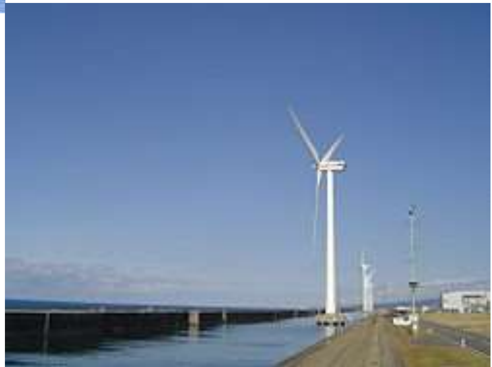
JRE酒田風力発電所
