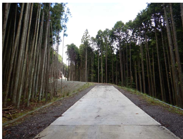
林道開設 中畑線（津市）
