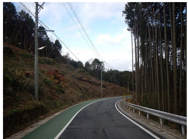
電線近くの危険木の事前伐採（名張市）
