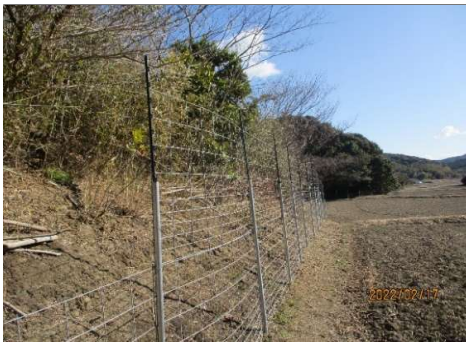
完成(R4.2)高低差箇所は嵩上げ
