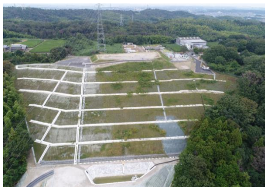
廃棄物埋立区域の整形覆土
