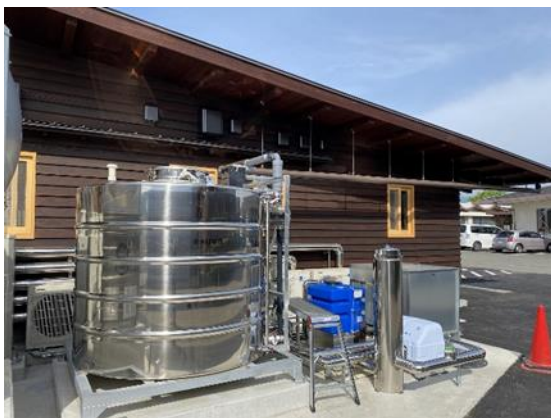
写真-7. 雨水利用施設
