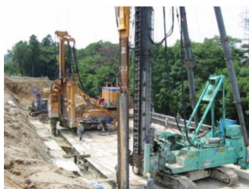
汚染地下水の拡散を防止する遮水壁の設置
