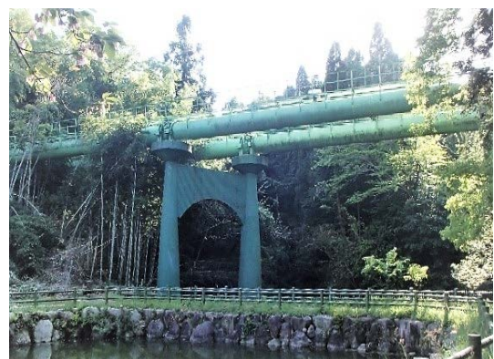
塗り替え予定の志知水管橋（桑名市）
