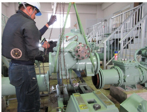
分解点検中の新屋敷取水所（松阪市） ポンプ設備
