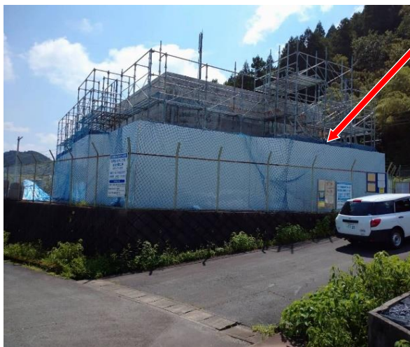
浸水・土砂災害対策工事中の勢和加圧ポンプ所（多気町）
