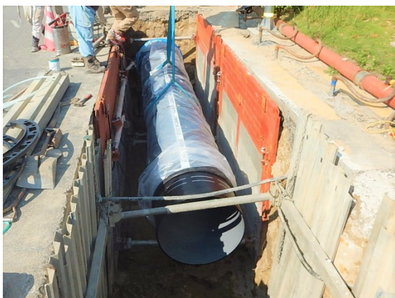
内径 900 耗配水管の布設替状況（四日市市）
