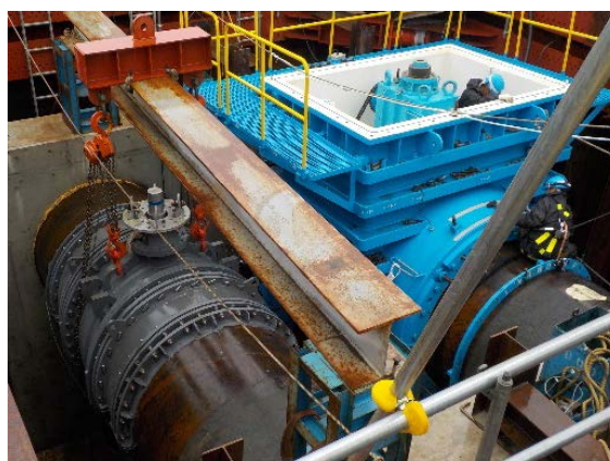
不断水工法*による制水弁設置状況
