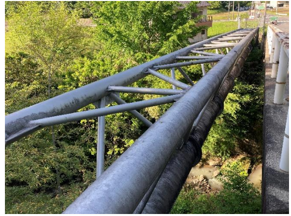
塗り替え予定の穴倉川水管橋（津市）
