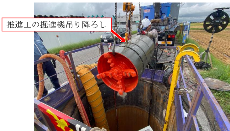
内径 400 耗送水管の布設替における 水路横断箇所での施工状況 (桑名市)
