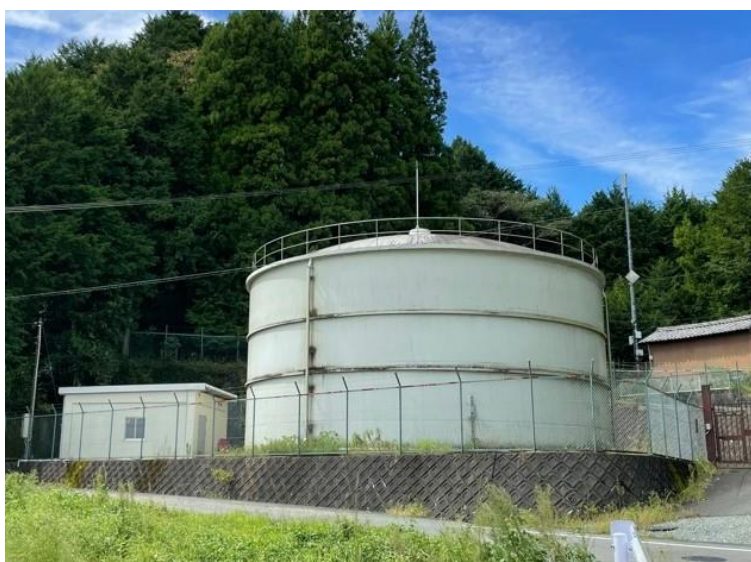
詳細設計中の長谷調整池（多気町）
