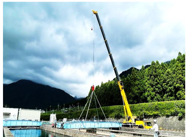
水沢浄水場（四日市市） 沈澱池汚泥掻寄機の撤去状況
