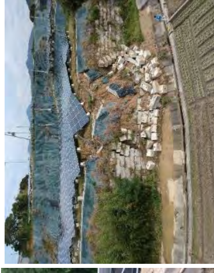
法面保護工が崩れて流出した事例
