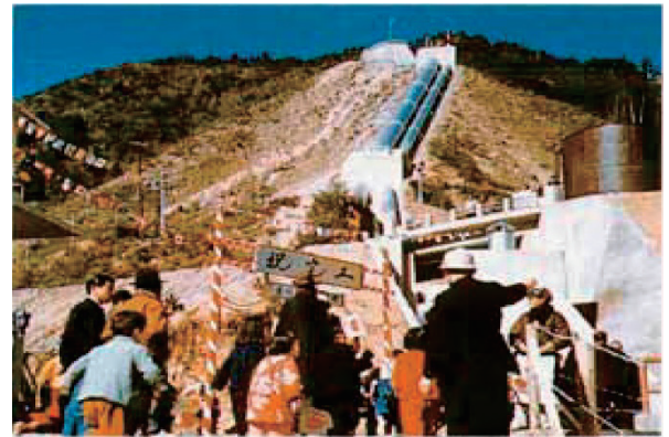
宮川第二発電所完工式
