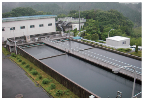
多度浄水場（撤去以前）
