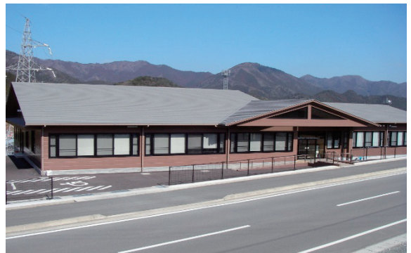
三瀬谷発電管理事務所
