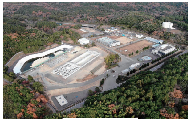
大里浄水場（全景）
