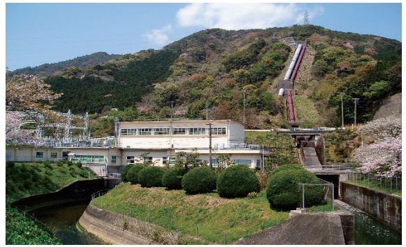
宮川第二発電所
