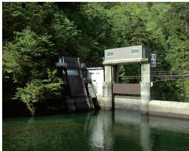
宮川第三発電所の取水口である不動谷ダム
