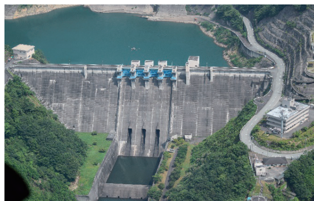
上空から撮影した蓮ダム
